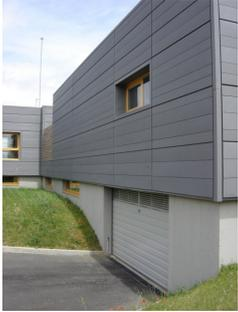
Sistema de paneles estrechos autoportantes dejando una huella como junta entre paneles.
