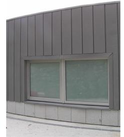
El sistema de panel de fachada cubre en muro encajando unos paneles estrechos entre si. La fijación es oculta. Se instala desde arriba hacia abajo, o desde un lado hacia el otro. Los paneles en si no admiten curvatura, con lo cual para revestir una fachada curvada en planta los paneles tienen que estar instalados en vertical.
